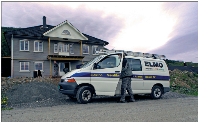
Eneboligene blir stadig mer avanserte med mye teknisk utstyr, slik som dette huset i Beinhaugen med blant annet vannbåren varme.
